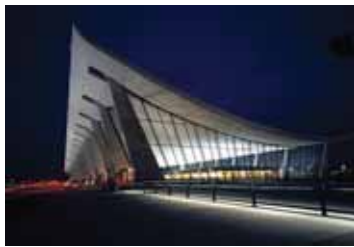
Techo del Aeropuerto Dulles de Washington (hipérbola y parábola)
